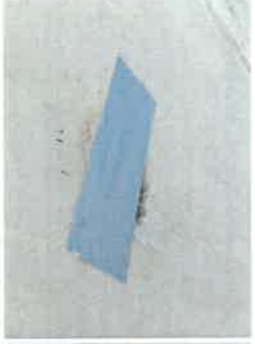
Illustration d'un drain colmaté au moyen de papier journal puis de Chatterton (Photo © Naturalia)
