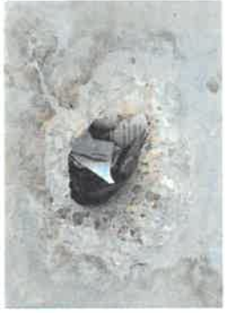
Illustration d'un drain colmaté au moyen de papier journal puis de Chatterton (Photo © Naturalia)
